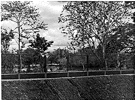
Foto N° 17 y 18. Mampostería en bloque 0.09 para cerramiento, alfagia en concreto, pañete para muros, concertina de seguridad, malla eslabonada y pintura en vinilo para muros.
