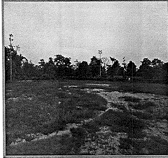
Fig. 43. Relleno con material seleccionado en el campo de juego
