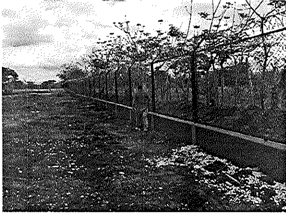
Foto N° 25 y 26. Mampostería en bloque 0.09 para cerramiento, alfagia en concreto, pañete para muros, concertina de seguridad, malla eslabonada y pintura en vinilo para muros.
