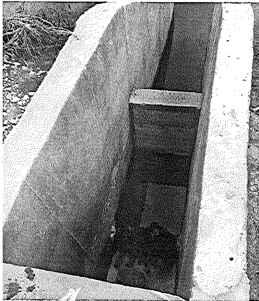
Foto N° 23 y 24. Estructura de paso y salida y válvula de compuerta
