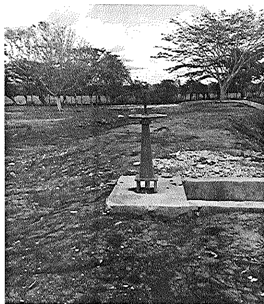
Foto N° 23 y 24. Estructura de paso y salida y válvula de compuerta
