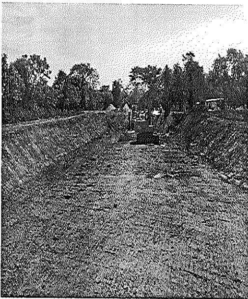
Foto N° 42 y 43. Construcción de lagunas
