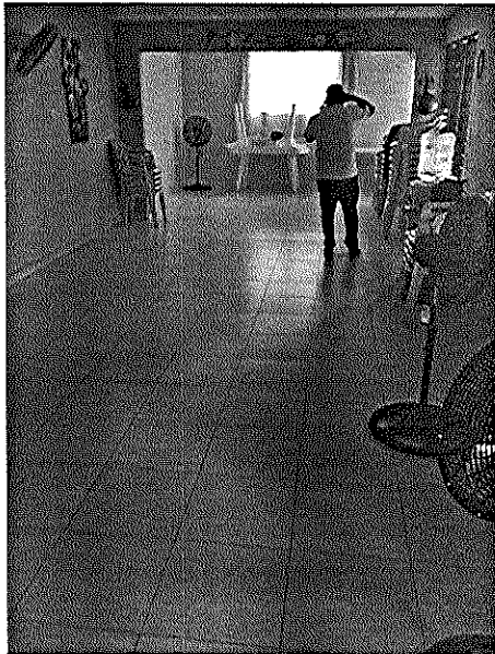
Foto N° 56 y 57. Suministro e instalación de cerámica y guarda escobas.
