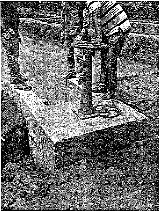
Foto N° 13 y 14. Estructuras de Paso y salida construidas, con su respectiva valvula.
