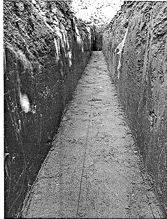
Foto N° 36 y 37. Relleno con arena alrededor de tubería sanitaria
