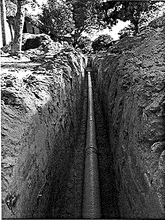
Foto N° 32 y 33. Instalación de tubería de 8"
