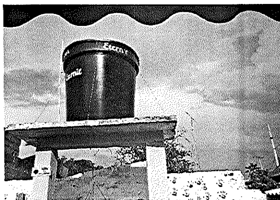
Foto N° 60. Suministro e instalación de tanque elevado.
