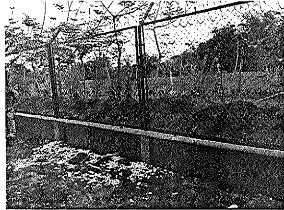
Foto N° 25 y 26. Mampostería en bloque 0.09 para cerramiento, alfagia en concreto, pañete para muros, concertina de seguridad, malla eslabonada y pintura en vinilo para muros.
