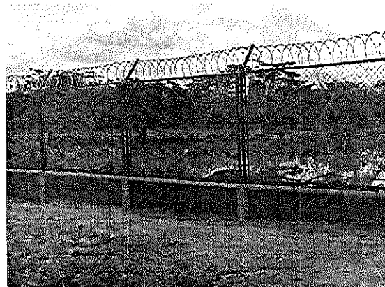
Foto N° 17 y 18. Mampostería en bloque 0.09 para cerramiento, alfagia en concreto, pañete para muros, concertina de seguridad, malla eslabonada y pintura en vinilo para muros.
