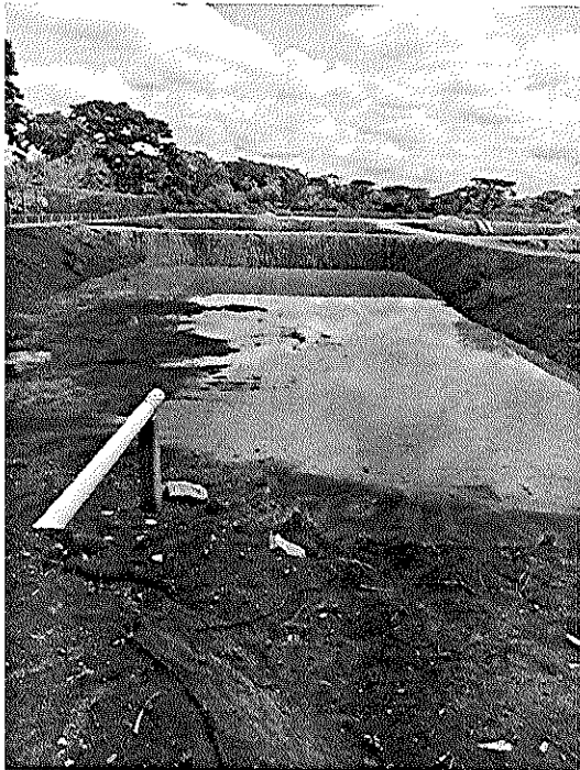
Foto N° 9 y 10. Construcción de 6 Lagunas de oxidación, distribuidas en 3 series de 2 lagunas
