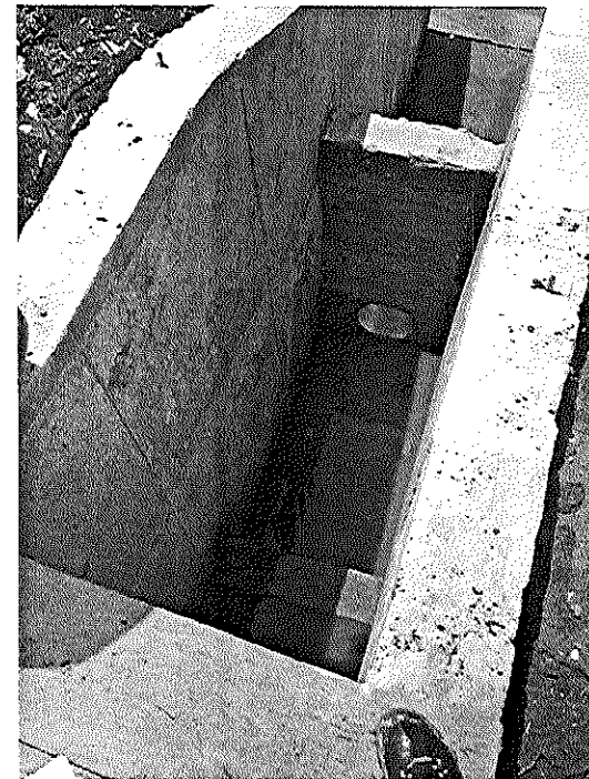
Foto N° 13 y 14. Estructuras de Paso y salida construidas, con su respectiva valvula.
