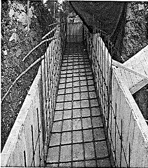
Foto N° 44 y 45. Construcción de Estructuras en concreto para paso y salida
